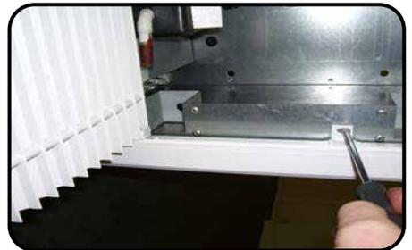
Bei VRF HP1500R und VRF HP2000R Geräten gibt es zwei zusätzliche Befestigungspunkte, einen in der Mitte des Geräts (wie in der Abbildung gezeigt),
