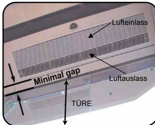
Stellen Sie sicher, dass in der Deckenaussparung oberhalb des Gerätes genügend Platz ist, die Lötarbeiten an der Verrohrung durchzuführen.
