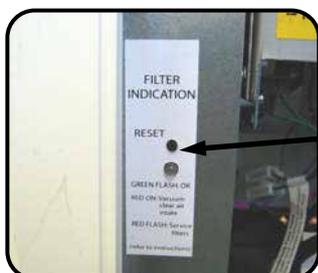
Klappen Sie den Einbaugrill herunter und setzen Sie die Anzeige „Filter verschmutzt“ nach erfolgter Reinigung durch kurzes Drücken des Rücksetzknopfes zurück.
