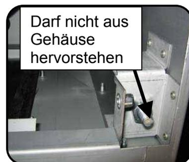
An beiden Enden des Gehäuses befinden sich jeweils 2 Gewindestangen (vier insgesamt), die von oben durch das Gehäuse gehen und nahe dem Boden des Gerätes in Halterungen eingedreht werden (siehe obige Abbildung - von unten in den Luftvorhang hin-einsehend). M10 Kontermuttern auf beiden Seiten der Halterungen dienen der Sicherung der Gewindestangen. Diese vier Gewindestangen dürfen nicht unten aus dem Gehäuse hervorstehen, da ansonsten der Einlassgrill nicht richtig eingesetzt werden kann.
