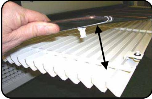
Der Lufterlassfilter kann nun von der Oberseite des Grills gelöst und zum Abbürsten und Absaugen vom Grill entfernt werden.
