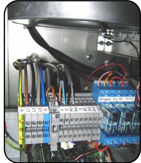
Falls erforderlich kann die Auftauzyklus-Zusatzheizung durch Abklemmen des Nullleiters (violett) von Zusatzklemme 14NO am Schaltschütz im Luftvorhang aktiviert werden. Dieser Draht wird dann auf dem Schaltschütz an Klemme A2 angeschlossen, wie in nebenstehendem Bild gezeigt (siehe auch Schaltplan 2 auf Seite 19).
