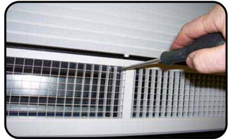
Mit geöffnetem klappbarem Auslassgrill wieder die Abhängstangen so einstellen, dass der Grillrahmen sauber an der Decke anliegt. Der Grillrahmen muss fest an der Decke anliegen und es dürfen an keiner Stelle Lücken zwischen Decke und Rahmen vorhanden sein.
