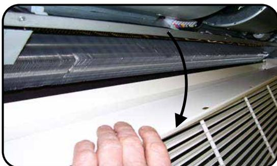
Die Vorderkante der Kondensatwanne klappt nun nach unten und die innere Oberfläche kann so gereinigt werden. Alle Fremdstoffe und Ablagerungen von der Heizschlange, der Auffangwanne, dem Auslassrohr, dem Kondensatschlauch und dem Kondensatabfuhrsystem entfernen.
