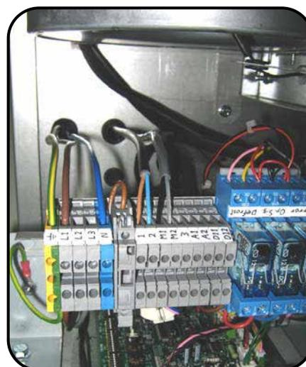
**2) Wenn die Auftauzyklus-Zusatzheizung während der Inbetriebnahme aktiviert wird, siehe Schaltplan 2, Seite 19 (400V/3Ph/50Hz Spannungsversorgung von separatem örtlichen Trennschalter)**
