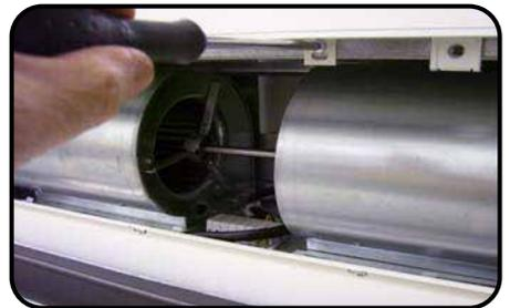
und einen in der Mitte des Auslassgrills, siehe Bild (Zugang zu dieser Schraube wird vereinfacht, wenn der ausgeklappte Einlassgrill temporär geschlossen wird).
