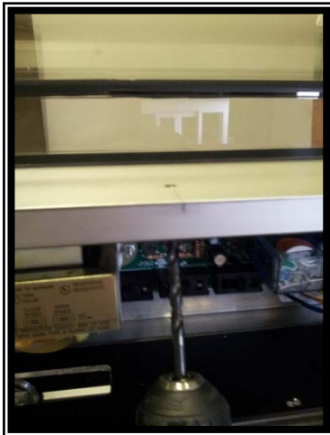
4 Percer les trous de montage sur l'AMB
